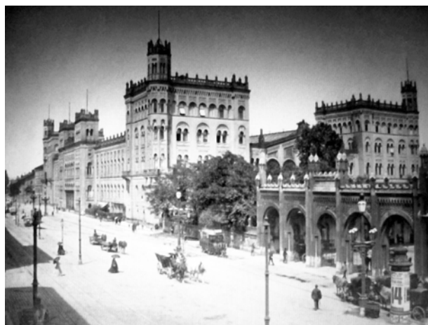
Fig. 4. Non-existing Wien Nordbahnhof. Photo Kaiser, W., 2011
